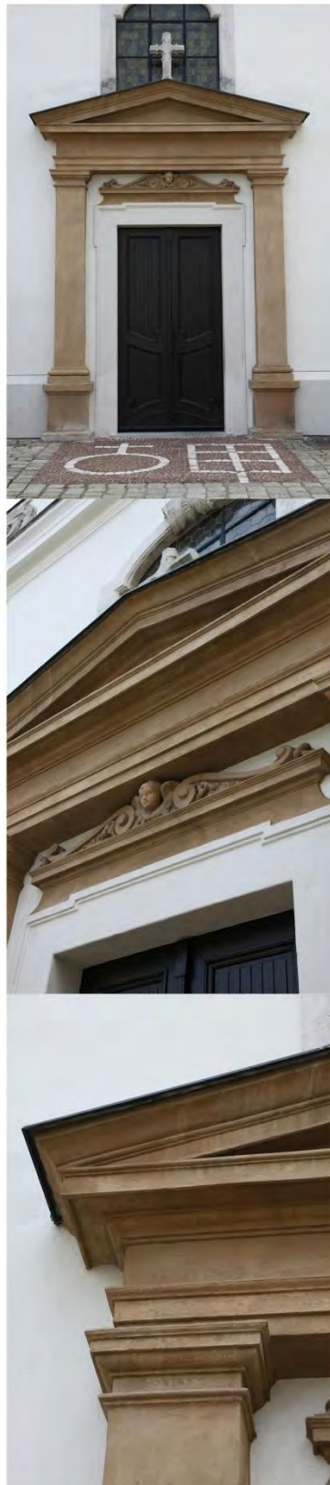
Portal der Altsimmeringer Pfarrkirche, Zustand 2019, schöner Alterungszustand
